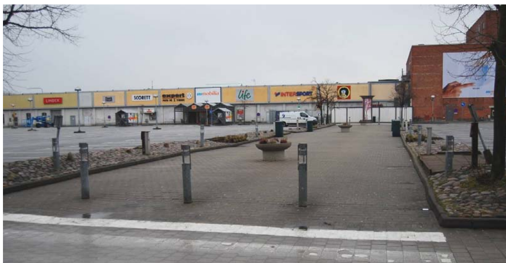
Figur 29. Gångstråket mellan byggnad A och B är idag kantad av refuger med kullersten.
