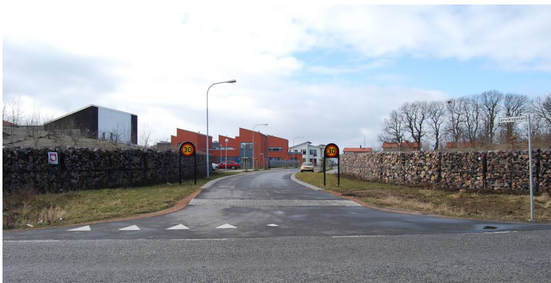
Figur 39. Entrén till ett nybyggt bostadsområde i Lomma består av två gabionmurar.
