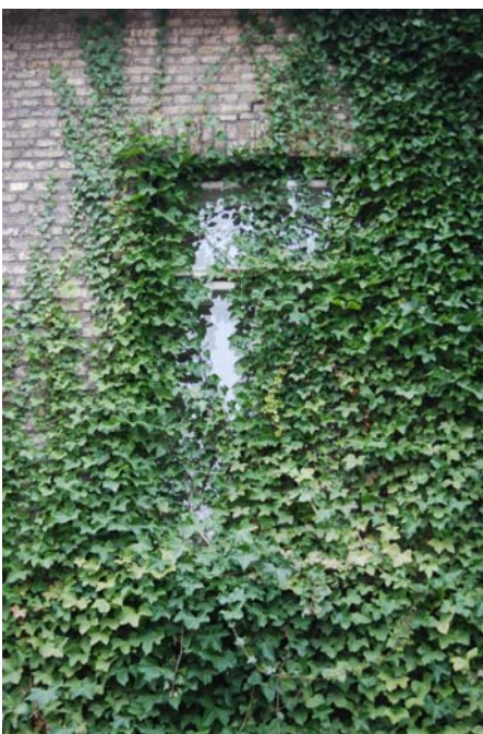
Figur 27. Återkommande beskärning bör ske för att inte fönster och fönsterkarmar ska ta skada.
