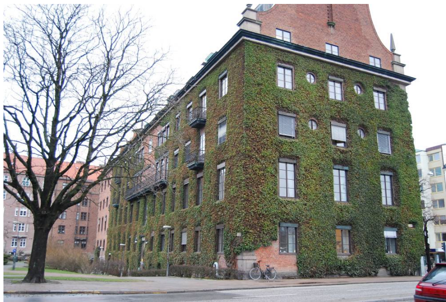
Figur 18. Fersensväg, Malmö. På husets skuggiga sidor bör städsegröna växter användas för att isolera byggnaden och hindra värmen inomhus från att försvinna ut.
