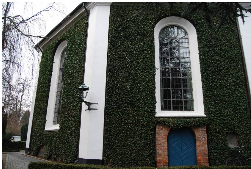
Figur 15. Städsegröna växter på Frederiksbergs kyrka kan ge en isolerande effekt på byggnaden.
