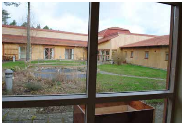
Bild 11: Viga vägen. Vegetation mot fasad
