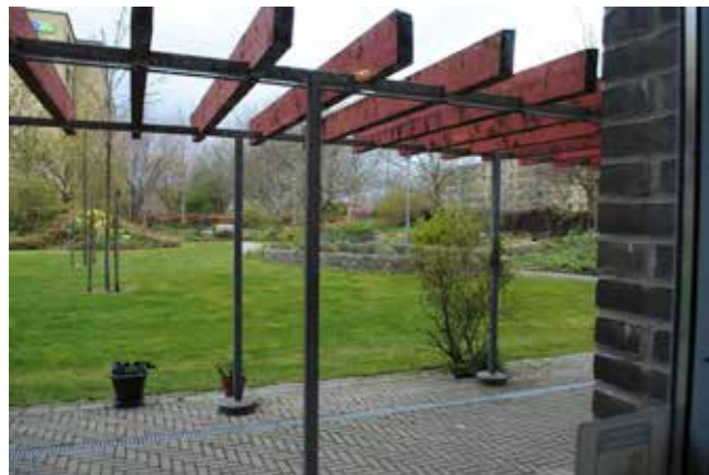
Bild 16: Stensjögatans äldreboende. Utsikt från nedanvåning - dagligverksamhet
