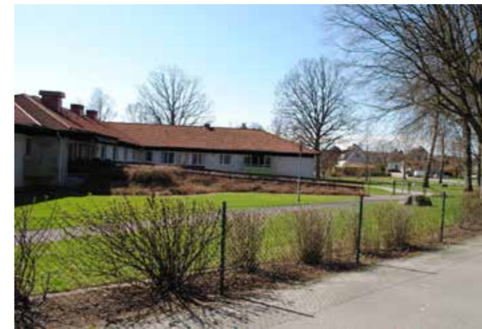
Bild 28: Vy 2 innan gestaltning
