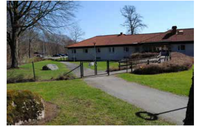
Bild 27: Vy 1 innan gestaltning
