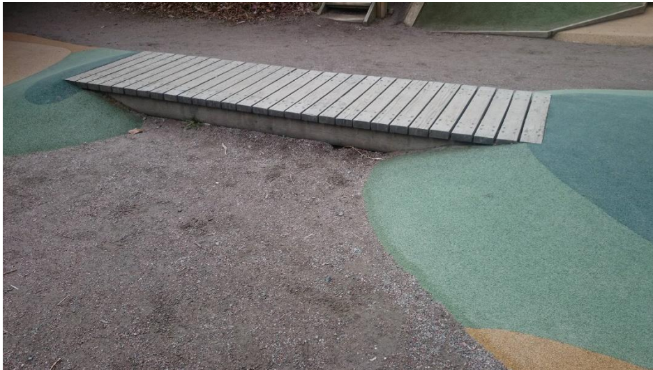
Bron är platt och har gjorts tillgänglig med avfasningar i gummimatta.
