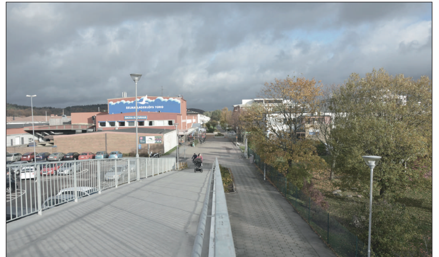
Figur 4. Vy mot norr från Backadalen. Idag är gång- och cykeltrafik separerad från biltrafik med en lång ramp från Kyrkåsberget.
