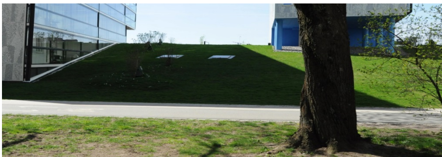
Figur 17. Bilden visar starka kontraster mellan sol och skugga samt den norra glasklädda fasaden som speglar. Foto taget vid besöket mellan klockan 12.00 och 13.00. Foto: Nima Karimzadeh 2016-05-10
