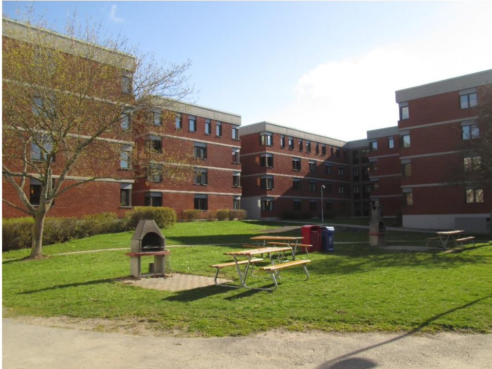
Ett av gårdsrummen på Lappkärrsberget. Gårdsrummet omges av tegelröda fyravåningshus. Här finns fasta grillar och bänkar. Foto: Elsa Bergebo 2016-04-20.
