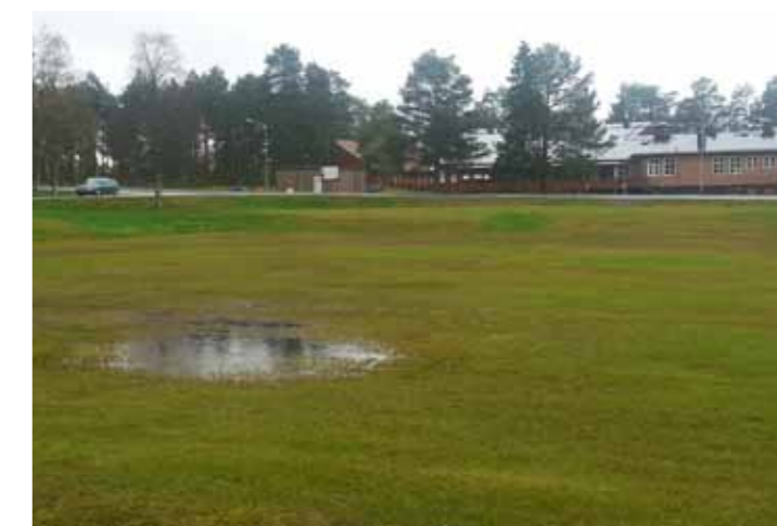
Grundvattennivåerna i Kronandalen är höga. Efter ett regn har det blivit stående vatten på en gräsyta. (2015-09-23)
