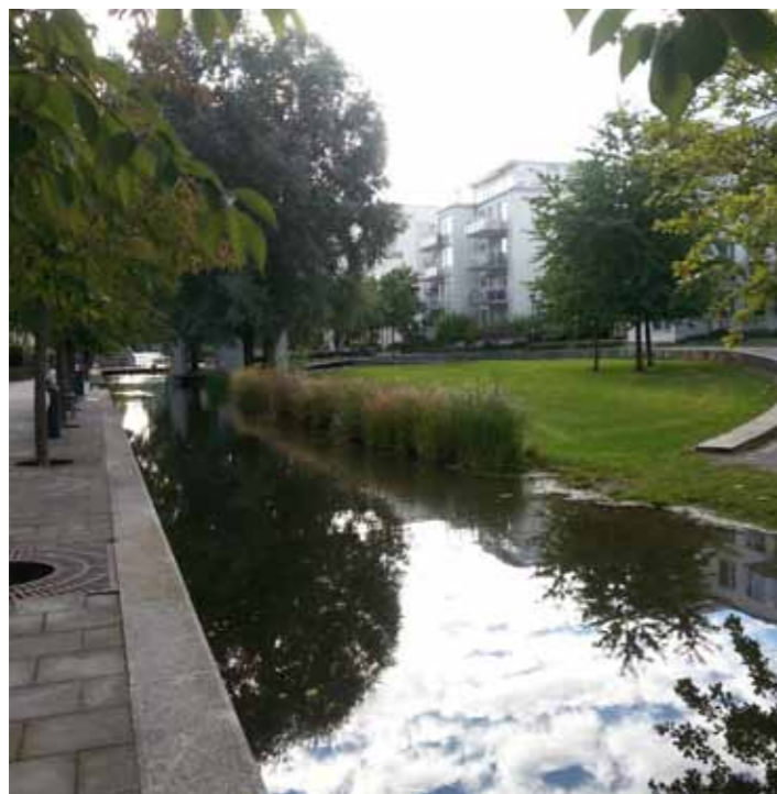
Ena kanten av dagvattenkanalen är belagd med granitsten och har en gångyta av plattor. Den andra sidan har en svagt sluttande gräsyta med vassvegetation på vissa sträckor. Det skapar en karaktär av både stad och natur. (2015-10-03)
