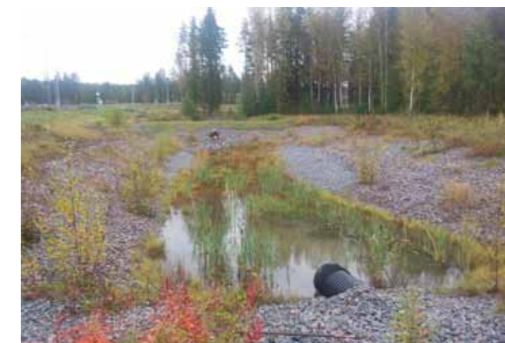
Befintlig dagvattendamm vid Bensbyvägen som ska ta emot dagvatten från Kronandalens grönstråk. (2015-09-23)
