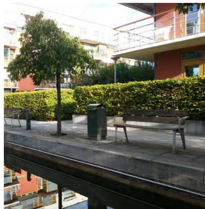
I Hammarby Sjöstad, Stockholm, används s.k. öppen dagvattenhantering där dagvattnet från bostadsgårdarna samlas i en dagvattenkanal där det renas innan det släpps ut i närliggande Hammarbysjön. (2105-10-12)
