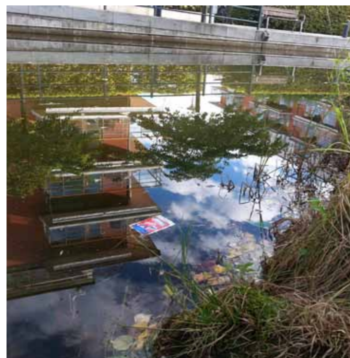
Dagvattenkanaler kan bli en skräpfälla, som här i Hammarby Sjöstad, vilket kräver ökad skötsel. (2015-10-03)
