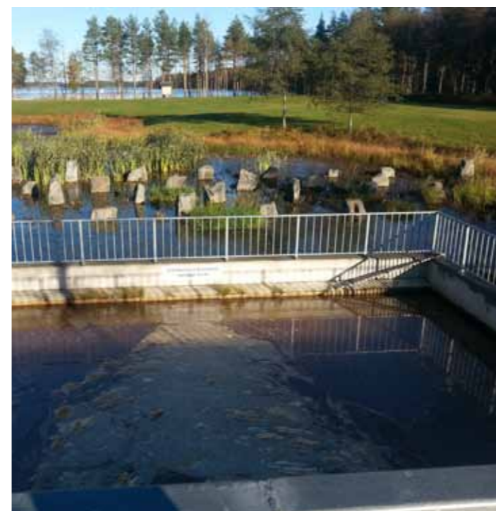
Förbehandlingsdammen omgiven av betong med staket ger en industrimässig känsla. Stenarna i dammen fördelar vattenflödet samtidigt som de är ett konstverk som förhöjer intrycket av dammen. (2015-10-13)
