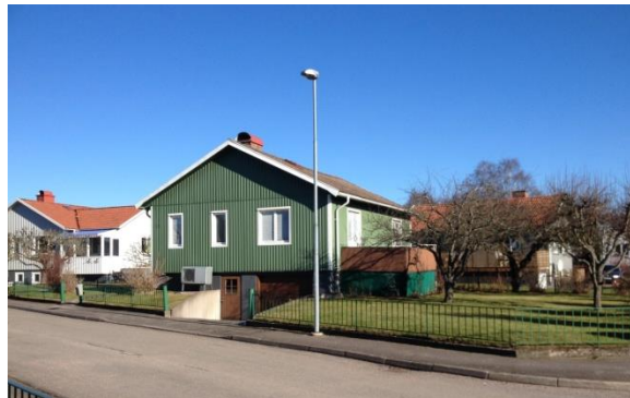
Bild 3. Hus från 1950-talet. Garaget ligger i källarvåningen för att spara yta. I trädgården står fruktträden fortfarande kvar. Hela tomten omgärdas av ett tidsenligt smidesstaket.
