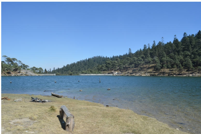
Figur 4.6. Utsikt mot dammluckan, Presa Iturbide.
