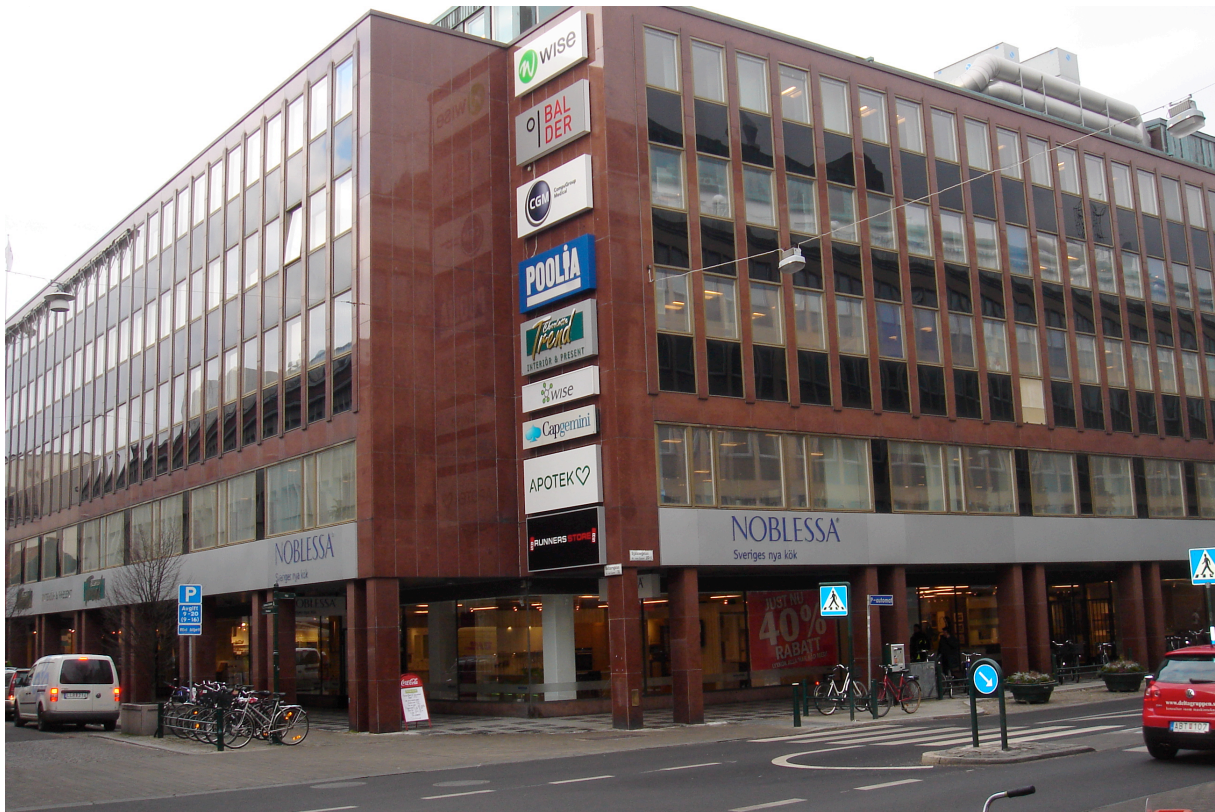
Bild 3. Fotografiet är från Sten i detalj- Byggnader (Barup, Edström, & Johansson, 2015) och visar ett helt kvarter i Malmö byggt 1965 med fasad av polerad Vångagranit. Den polerade ytan är väl synlig och ställer därför mycket stora krav på exakt färg och mönster.
