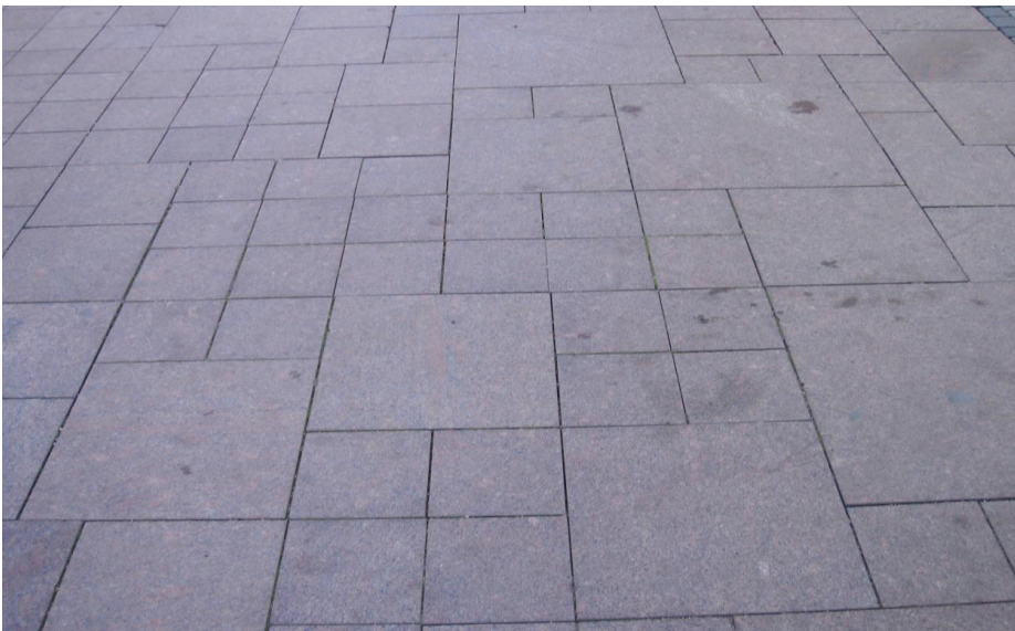
Bild 7. Körbana belagd med flammade hällar där kravet på jämn färg och mönster är lågt. Från Sten i detalj- Utemiljöer (Bensch & Fors, 2011)
