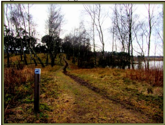
Figur 18. En bit av den befintliga sträckan som har dåligt underlag.
