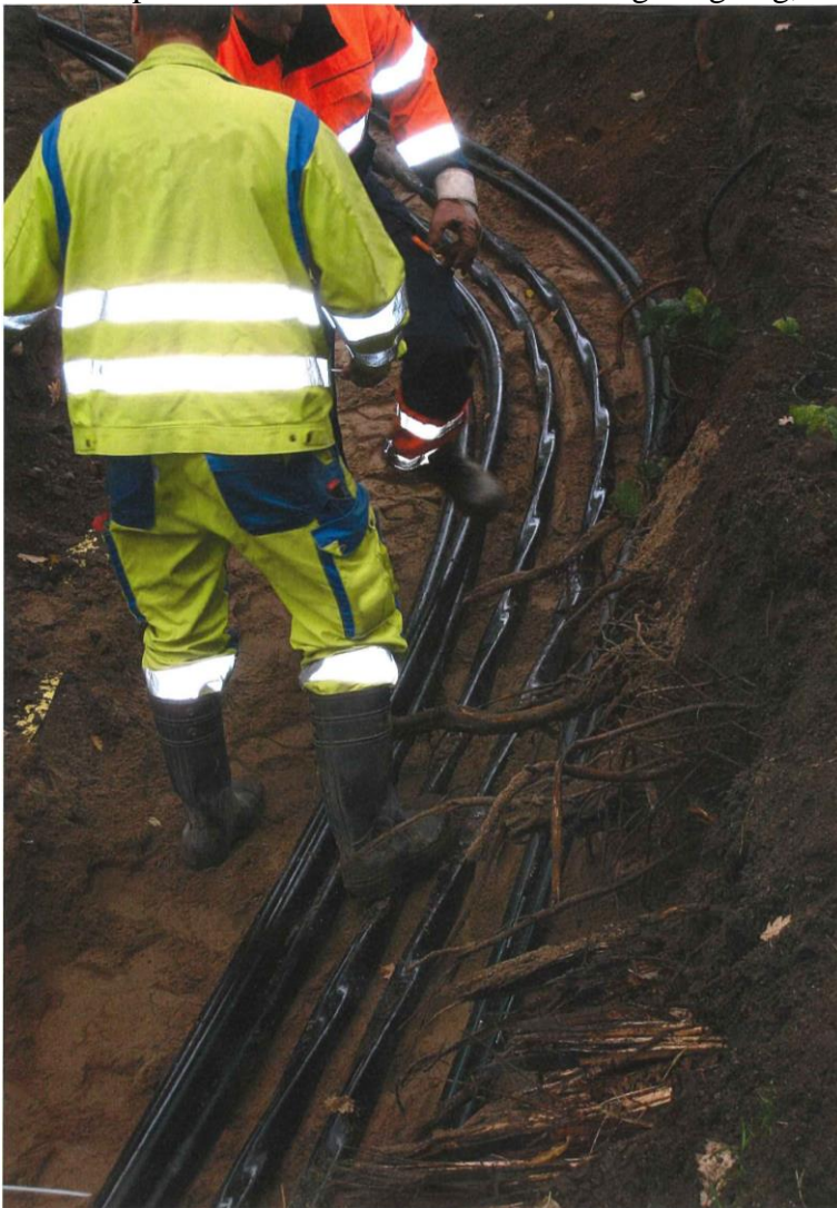
Fig. 1. Grävning i park (Ulf Klang).
