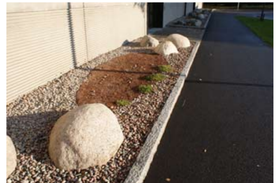
Asfalt, singel, granitkantstöd och stenblock. Förgårdsmark vid kvarteret Brandstationen, Eddagatan, Uppsala.
