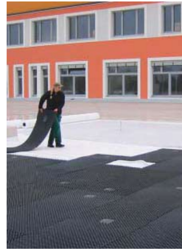
DiaDrainskivor läggs ut på bjälklag för att förbättra både dränering och vattenhållande egenskaper. Foto: Byggros
