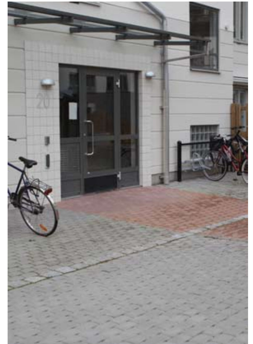
Förändring i betongplattornas färg tydliggör entrén. Bostadsgård i Kungsängen, Uppsala.
