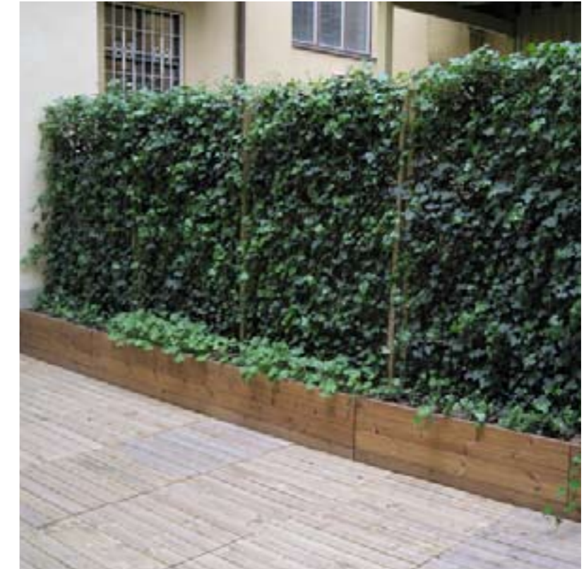
Växtskärm av murgröna. På detta sätt kan man snabbt skapa gröna volymer med ett litet jorddjup. I Uppsala riskerar dock murgröna som är exponerad på detta sätt att skadas av vind och frost. Foto: VegTech.
