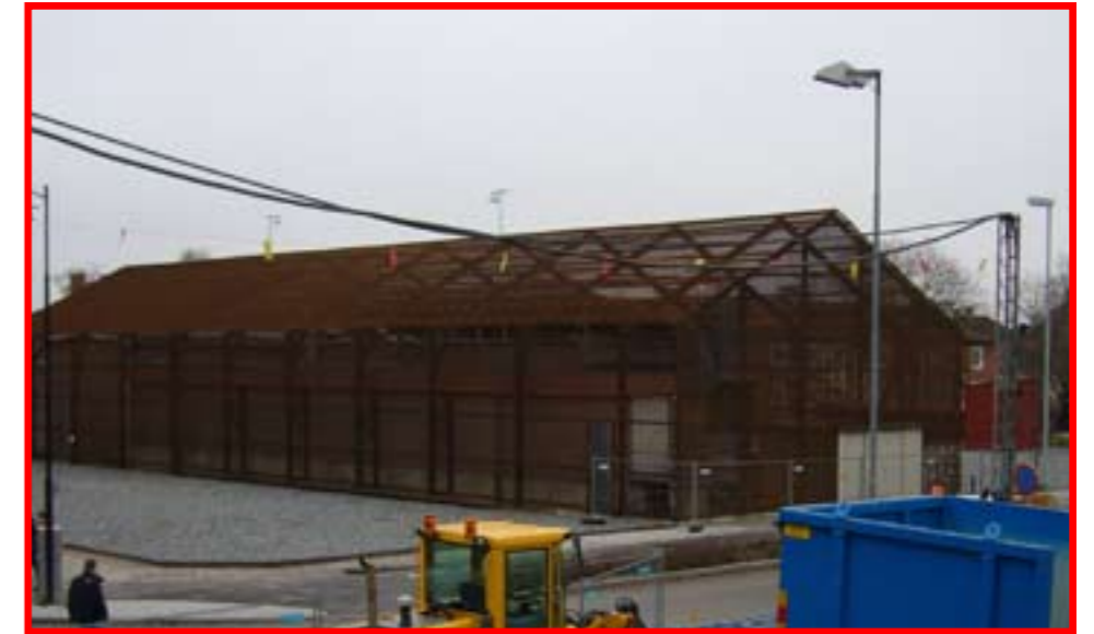
3 - Transformatorstationen i norra delen av Mjölnerparken kläs in i galler där klättrväxter sedan ska växa.
