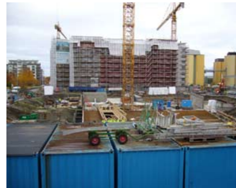
Arbetet med grundläggningen av kvarteret Mjölaren är i full gång.
