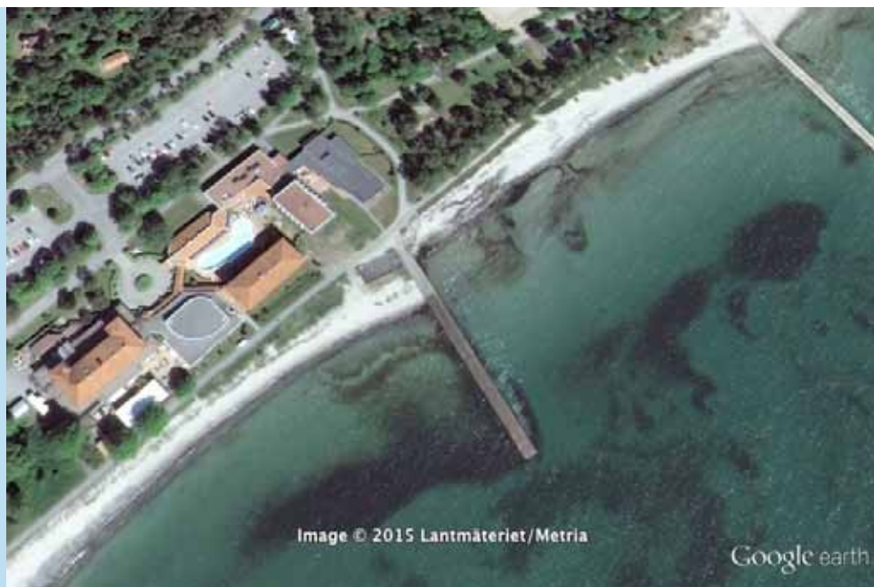
Figur 21: Ystad saltsjöbad - Ett tydligt exempel på hur hårda strukturer kan få sand att ackumulera, men förvärra erosionen nedströms Foto: Google Earth, Lantmäteriet/Metria
