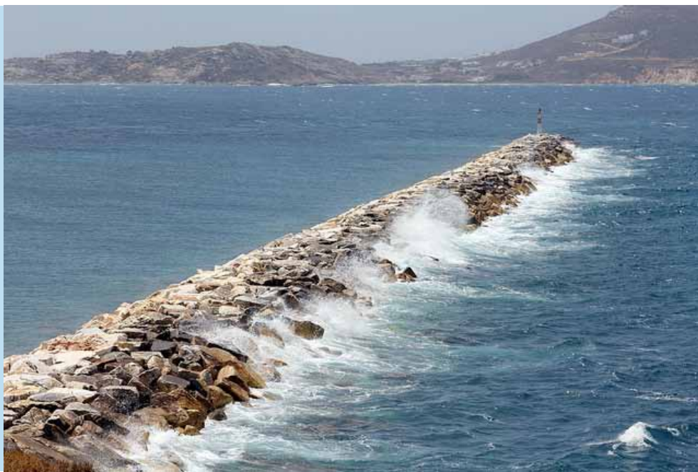
Figur 17: Vågbrytare - ett hårt skydd Foto: Tilemahos Efthimiadis (CC BY SA)
