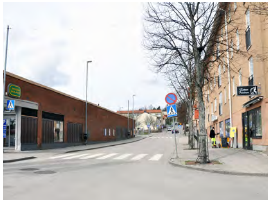
Götgatan med sikte norrut. Coop och Systembolaget till vänster och mindre verksamheter till höger.
