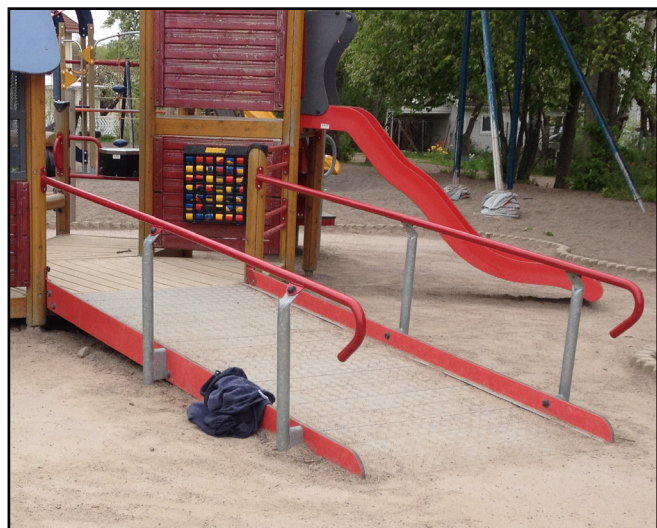
Bild 2. En ramp upp till klätterställning underlättar för rörelsehindrade och synskadade barn. Foto: Sandra Malmberg (2014).
