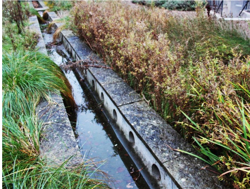
Figur 4. Fördröjningskanal där vegetation minskar mängden vatten genom upptag och evaporation. Överskottsvatten rinner ner i kanalen via hålen.
