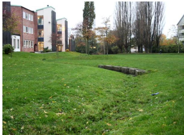
Figur 6. En grässänka som slingrar sig igenom en öppen yta i Augustenborg. I grässänkan finns ett antal fyrkantiga planteringskärl i betong. Dessa är avsedda för plantering av större växtmaterial.
