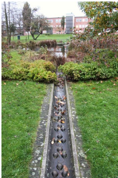
Figur 15. En strikt fördröjningskanal som leder till en dagvattendamm.
