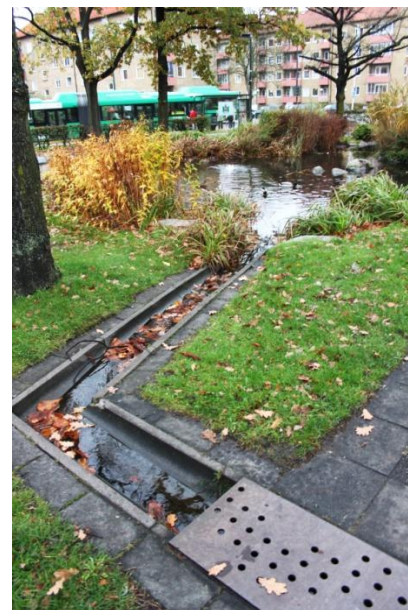
Figur 2. En gjuten fördröjningskanal som leder till en dagvattendamm i Augustenborg i Malmö.
