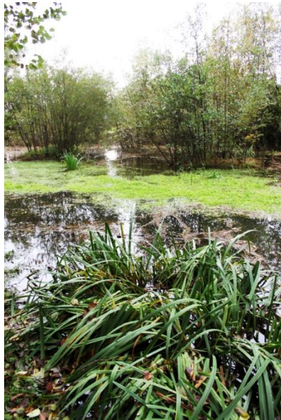
Figur 7. En öppen dagvattenanläggning i Alnarp som efter kraftigt regn är fylld med vatten. Hösten 2014
