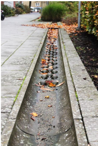
Figur 14. En strikt fördröjningskanal.
