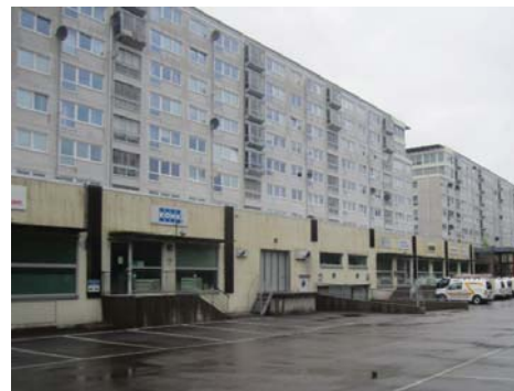
Parkeringsgarage ombyggt till företagscenter
