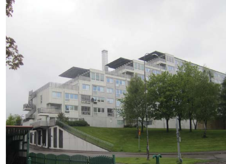
Ombyggt terrasshus i östra Gårdsten
