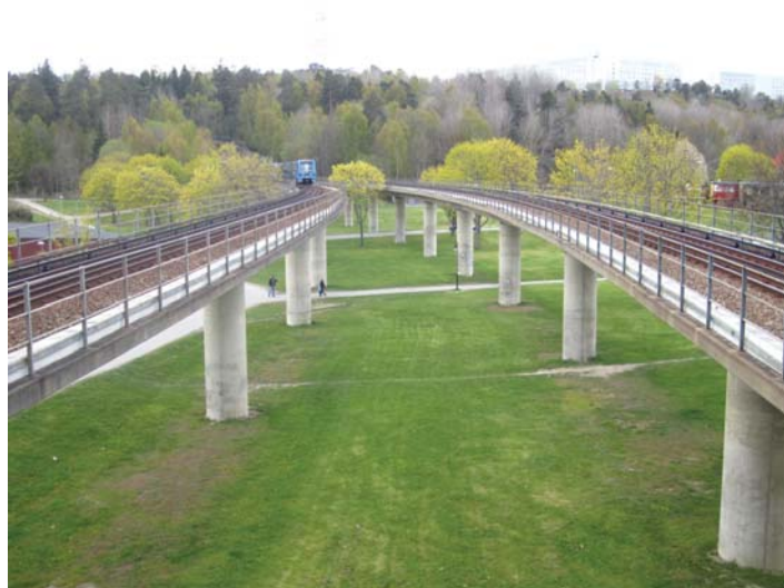
Tunnelbaneviadukten i Fittja
