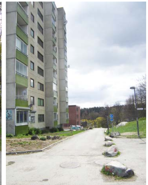
Stråk söder om centrum. Grönområdet till höger i bilden planeras att förtätas.
