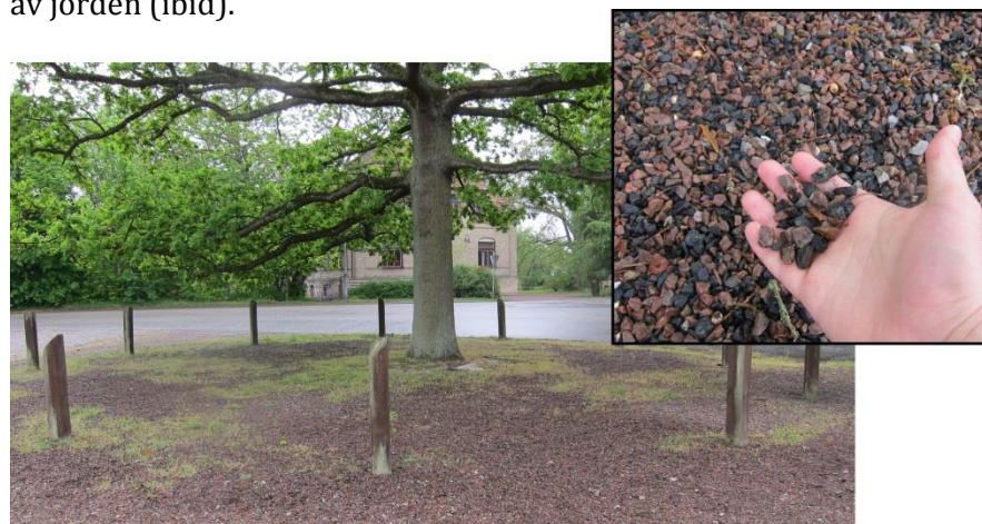
Figur 19 Stolpar sattes upp runt kronans dropplinje för att undvika fortsatt fordonstrafik och därmed kompaktering. Uppe till höger syns slitlagret av makadam vilket är av enformig större fraktion (grus) som därmed har god infiltration av vatten till underliggande växtbädd. Foto: André Olsson (2013-05-21)
