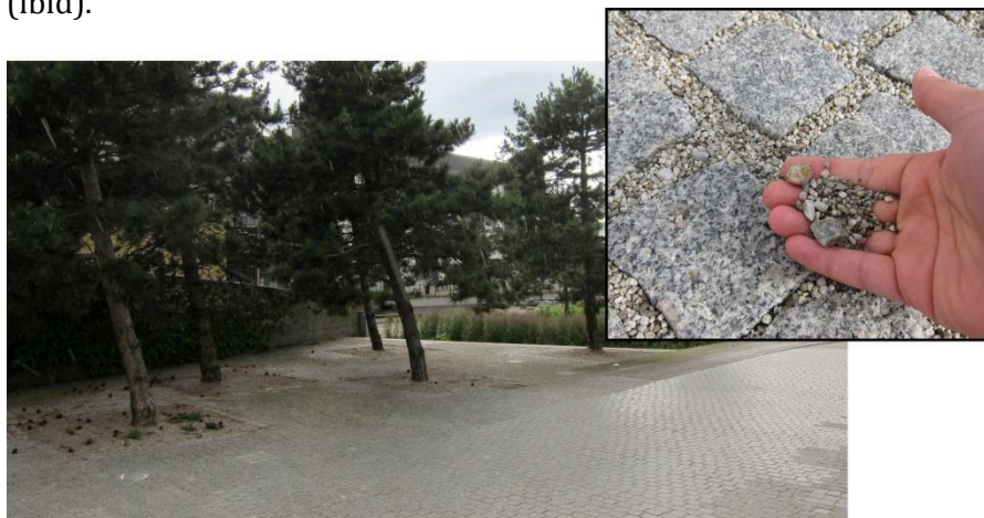
Figur 12 Traditionellt sett får träd planterade i hårdgjorda ytor lite vatten då den mesta av nederbörden leds bort av dagvattenhantering och ej når växtbädden. Med hjälp av ett genomsläppligt markmaterial återförs istället vatten till växtbädden. På bilden en smågatstensyta utanför Turning Torso i Malmö med många fogar av större enformig fraktion (grus), vilket ökar infiltrationen. Foto: André Olsson (2014-06-24)
