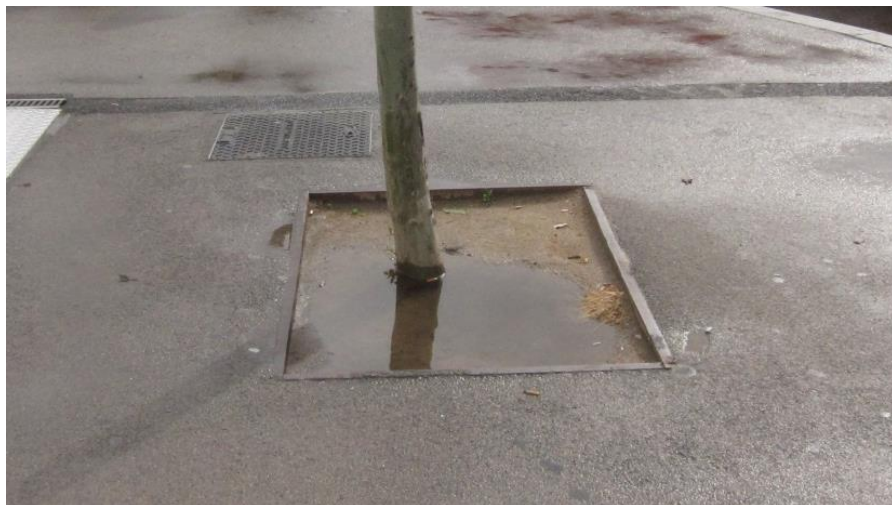
Figur 7 Träd planterade i hårdgjorda ytor har som regel långt ifrån ideala levnadsförhållanden. Trädet på bilden har en minimal planteringsgrop. Växtjorden är dessutom kompakterad vilket leder till att vatten inte kan infiltrera jorden utan blir stående. Foto: André Olsson (2013-04-27)
