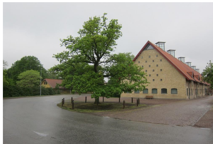
Figur 18 Lokalen vid Alnarpsgården. Foto: Andrée Olsson (2013-05-21)
