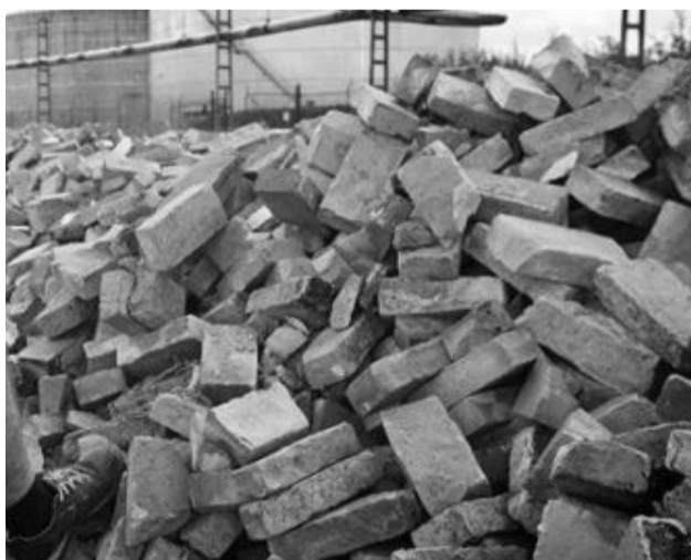
Fig. 22. Teglet från den demonterade Benmöllan bearbetas och lagras vid Malmö Återbyggdepå innan den återanvänds som tegelmur vid Malmö Live.
