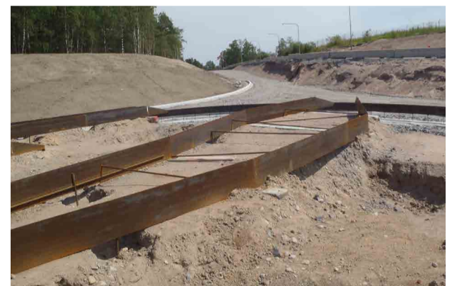
Fig. 75. (nedan) Rondellen under byggnationstiden.
