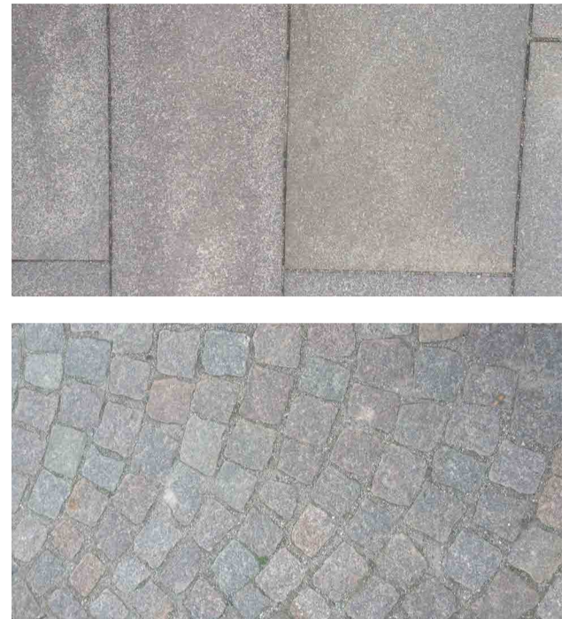
Fig. 42. & 43. (under) Återvunnen stenmjöl från krossad betong från Miljöfabriken används i fogarna mellan granithällarna och gatstenarna.
