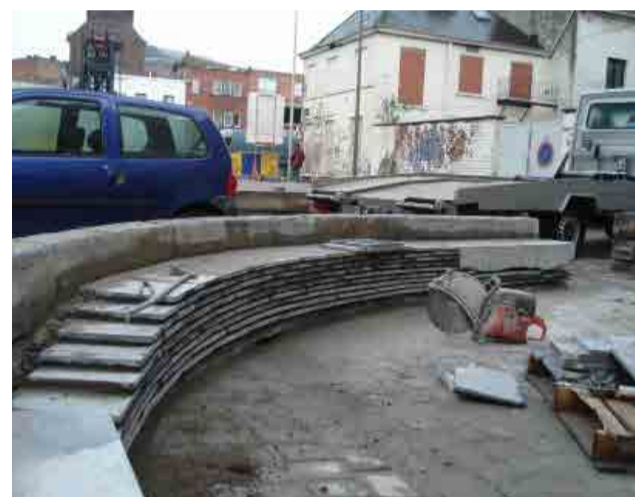
Fig. 96 & 97. (höger) Bänken anpassas efter materialets förutsättningar under byggskedet.
