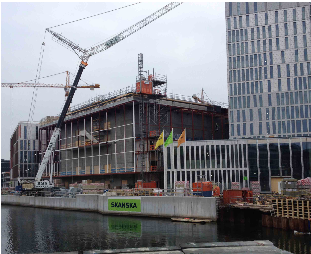
Fig. 20. Vy över pågående byggnation vid Malmö Live.
