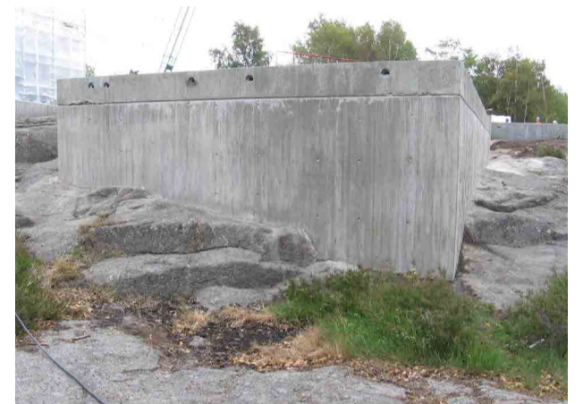
Fig. 113. (under) "Berg i dagen" gjuts in i formgjuten betong.
