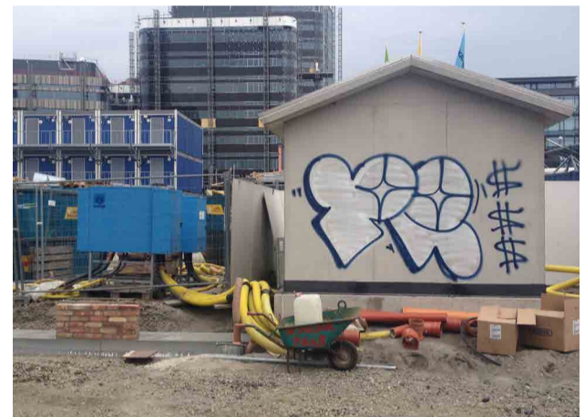
Fig. 28. (under) Inledande tegelläggning av mur på Malmö Live.
