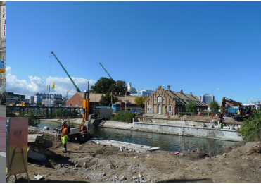
Nybyggen på gång - KKH och WMU
