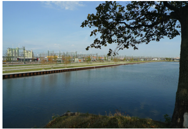
Ny anläggning längs med järnvägen
