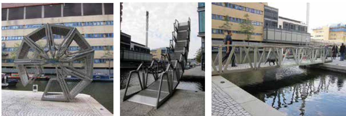
Bilder 13-15. Rolling Bridge av den brittiske arkitekten Thomas Heatherwick visar hur en tillämpning av naturens utvecklande formteknik kan se ut. Bron är inspirerad av en muskulatur och vecklas genom hydraulik ut när fotgängare behöver passera kanalen.
