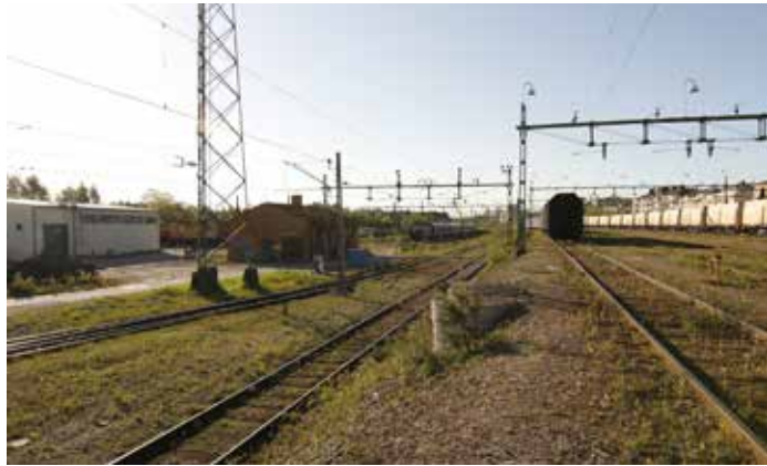
(A) Belysningsmast, huvudbanvallen till höger, vy mot öster.
