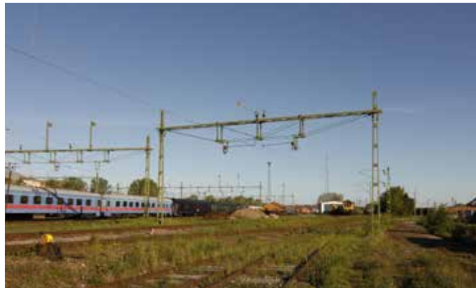
(B) Kontaktledningsbryggor, vy mot väster.
