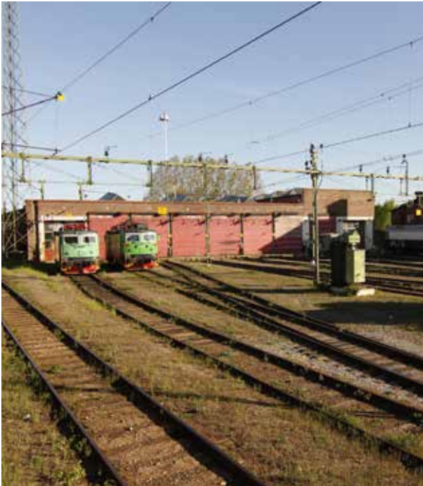
Lokstationen (2). Verksamheten i byggnaden bedrivs idag av Green Cargo.
