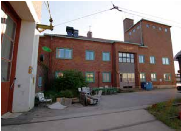
Lokstationen (2). Uppförd 1940 i samband med utvidgningen av bangårdsområdet. Parallelstall med 9 portar. Byggnaden i vinkel är kontor, ursprungligen delvis vattentorn. Ingår ej i den kulturhistoriska analysen.
