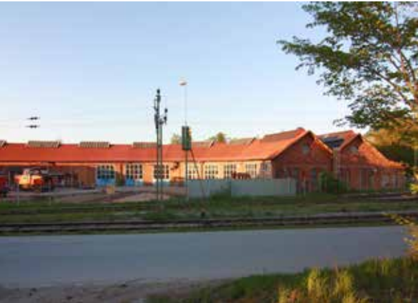
Verkstäderna (3). Byggnadskomplex uppfört i etapper mellan 1870-1930. På bilden ses rundstallet med 8 portar och tillhörande vändplatta.
