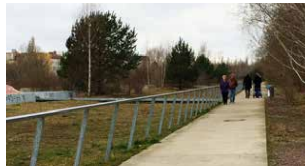
Huvudstråket i betong och staketet som "skyddar" ängen.
