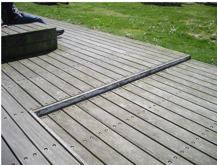
Figur 6. Träkonstruktion på marken av azobé i västra hamnen, Malmö.
