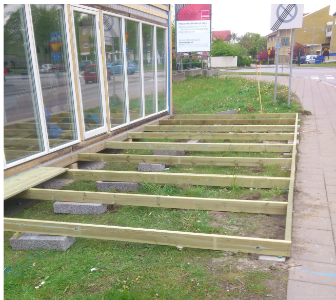
Figur 2. Påbörjat trädäck av tryckimpregnerat furuvirke i centrala Lomma.
