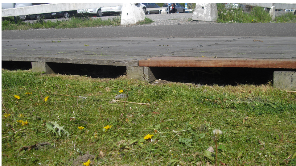
Figur 7. Trä på marken anlagt med luftspalt vilket ger möjlighet för träet att torka upp. Västra hamnen, Malmö.
