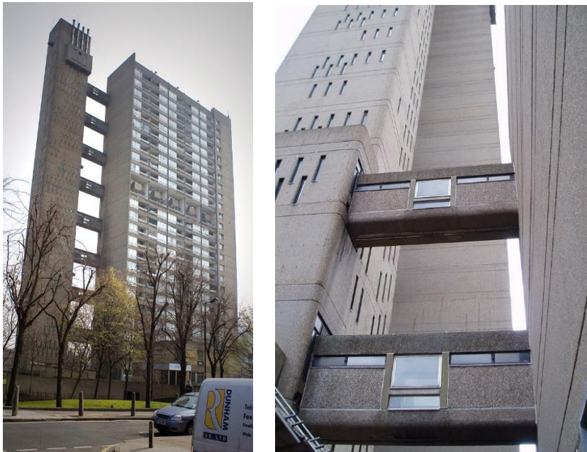
Figur 2 och 3 Balfour Tower och Trelick Tower
