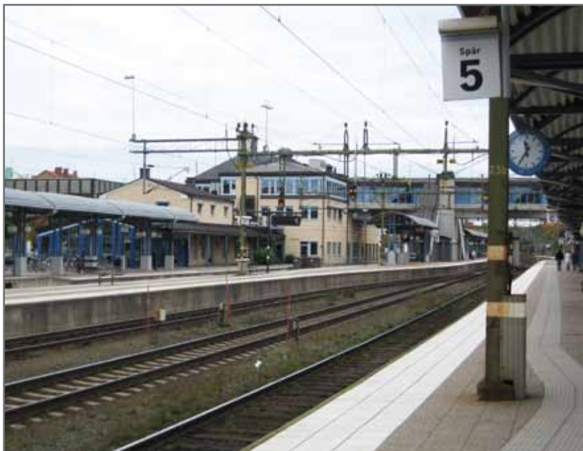
Stationen med övergången, sedd från perrongen norrifrån. Till vänster i bild ses väntplatser för bussresenärer.. (Lönnbom, 2013)
