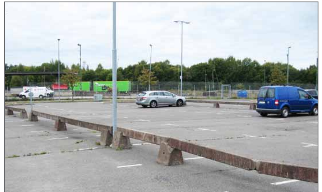
Parkeringen mot gång- och cykelvägen. (Lönnbom, 2013)
