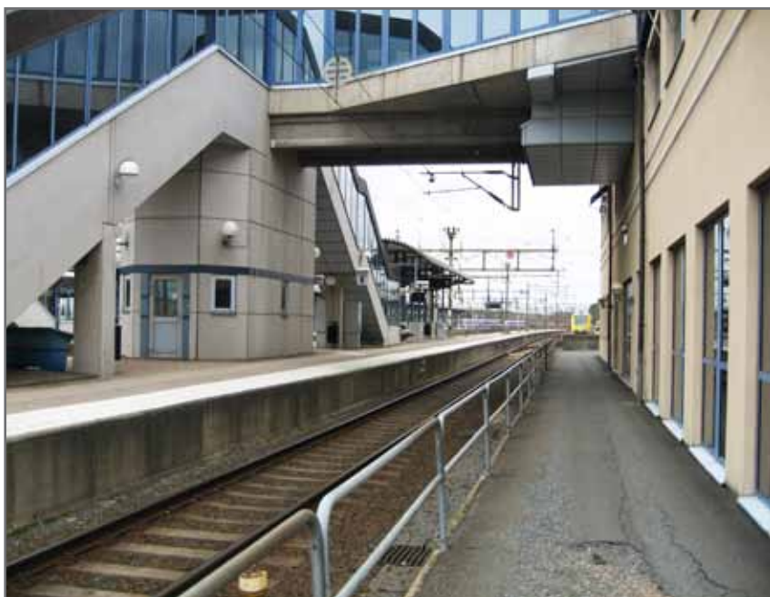
Bilden är tagen från perrongen närmast stationsbyggnaden. I övre delen av bilden ses övergången. (Lönnbom, 2013)
