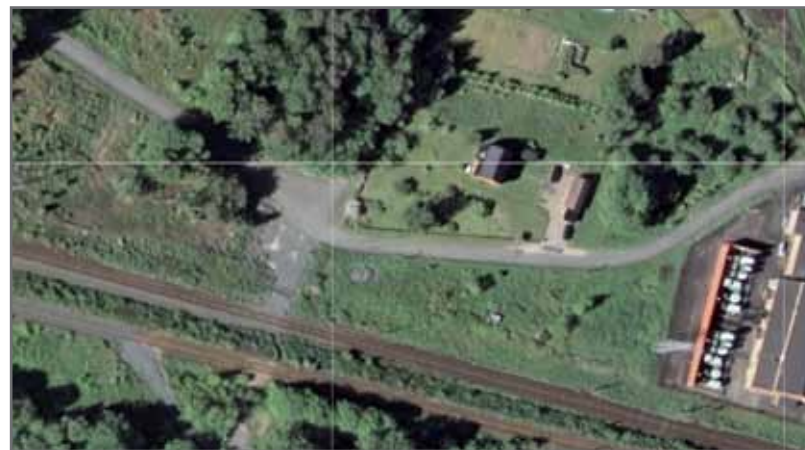
Till höger ses en del av elcentralen och i mitten finns ett bostadshus med omgivande landskap. (Google maps, 2011-10-22)
