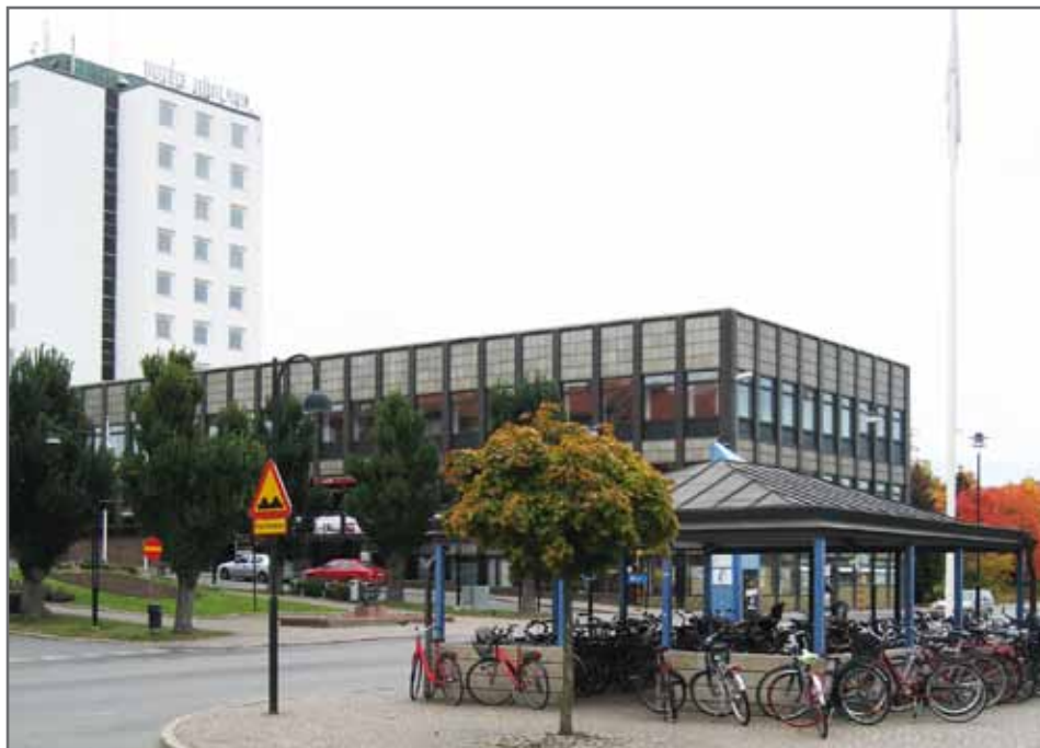
Cykelställ framför stationsbyggnaden. Till vänster i bild leder Esplanaden upp till torget. (Lönnbom, 2011)
