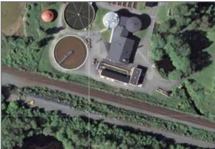
Avloppsreningsverket. (Google maps, 2011-10-22)
