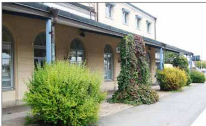
Södra delen av stationsbyggnaden, sedd från perrongen. (Lönnbom, 2013)
