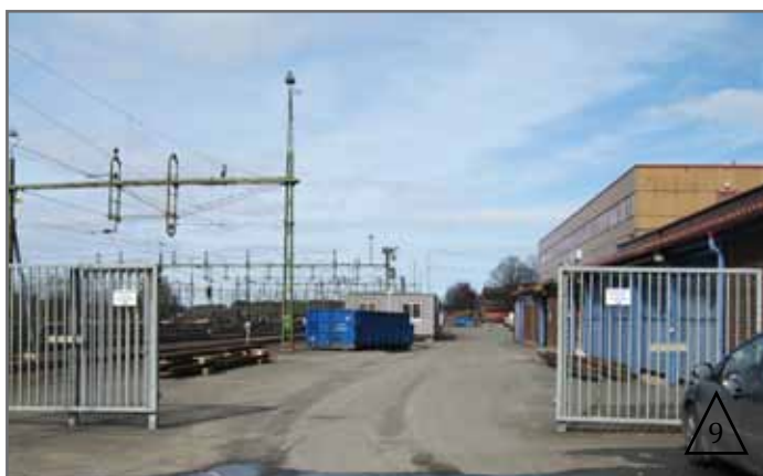
Industri i anslutning till järnvägsspåren. (Lönnbom, 2011)
