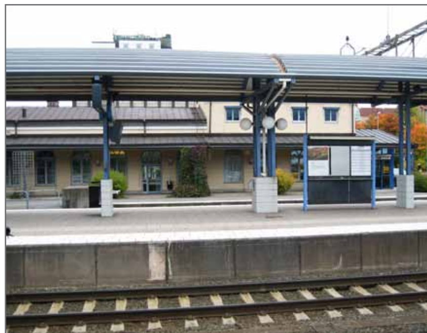
Vy mot den södra delen av stationsbyggnaden. (Lönnbom, 2013)
