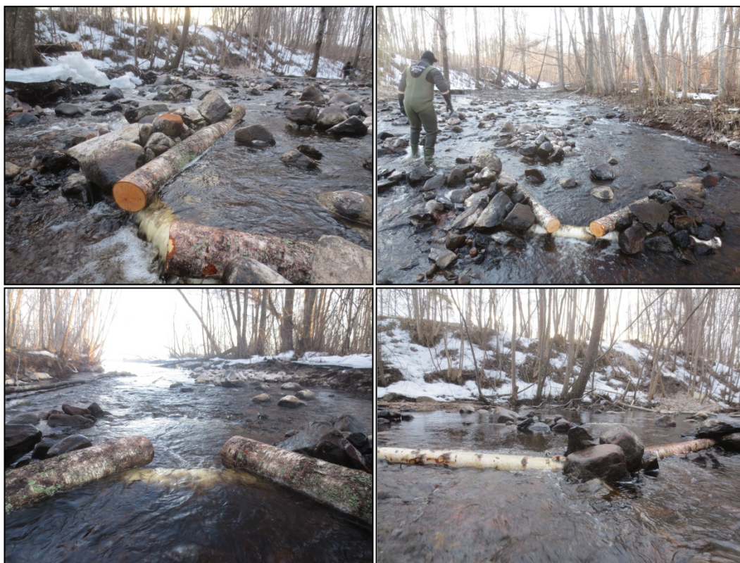
Figur 11. K-dammen tvingade en del av vattnet att ta sig över en tvärliggande stock för att sedan gräva ut en djuphölja nedströms. Fotot längs ner till vänster visar den andra konstruktionen med två tvärliggande stockar. Fotograf: författaren
