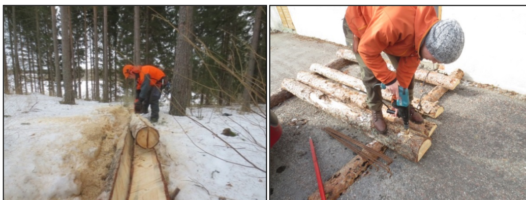
Figur 7. Framsågning av så kallade Half logs ur en tallåga. Bitarna kapades i 2,5 meters delar för att sedan sågas isär. Genomborrning skedde i vardera änden för armeringsjärnen. Fotograf: Tomas Malmqvist
