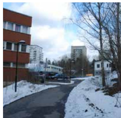
15. Verksamhetsområde med kontor och byggnader av industrikaraktär. Glest mellan husen och mycket asfalt.
