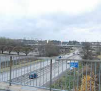
12. Utsikt från bron åt öster. Träden och parkeringsplatsen vänster i bild tillhör Stockholmsmässan.
