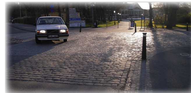
Exempel på en upphöjd korsning i Varberg.
