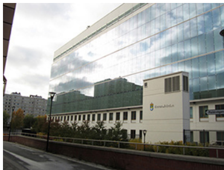
Intill järnvägen ligger ett stort häkte som är en av Malmvägens nya grannar.
