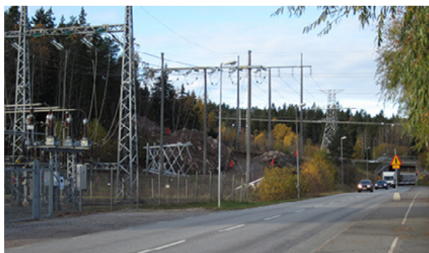
Så här ser det ut på längs Knistavägen strax innan tunneln mot Järvafältet.
