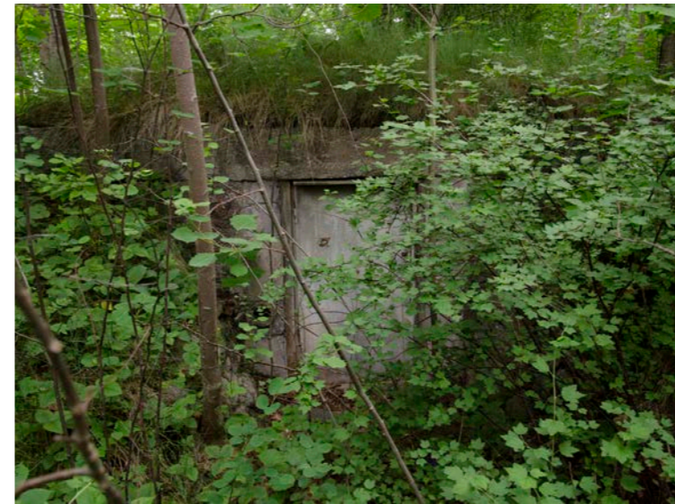
Den befintliga jordkällaren blir en spännande "ruin".
