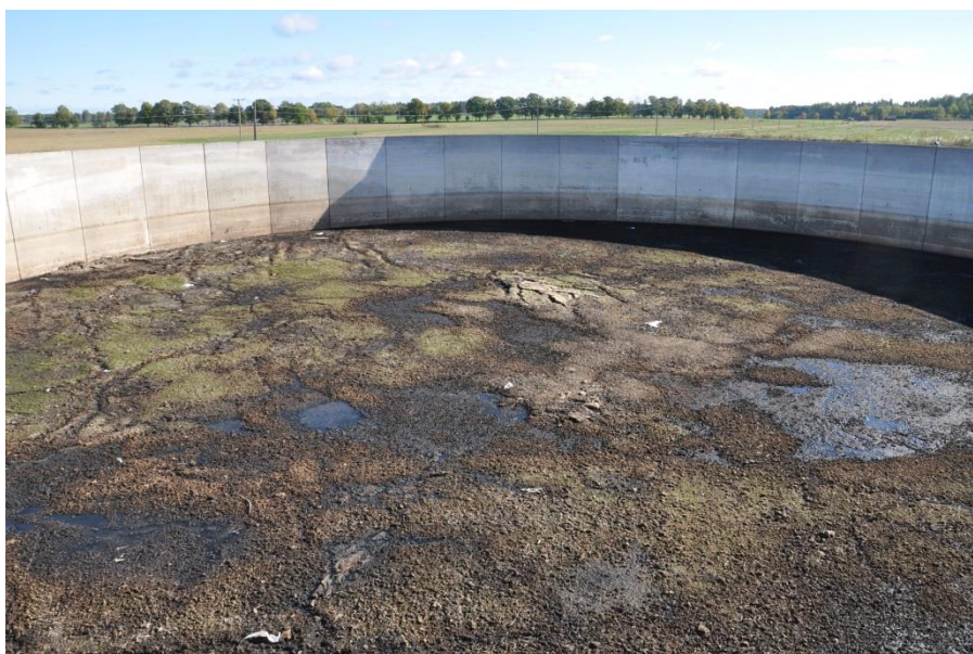
Figur 2: På bilden syns en så kallad brunn där gödseln förvaras. Dessa brunnar utgör en viktig del i att driva en biogasanläggning genom att ta emot och lämna gödsel. Gödseln som syns på bilden är grundstommen i biogasproduktionen. Foto: Rickard Gustafsson.
