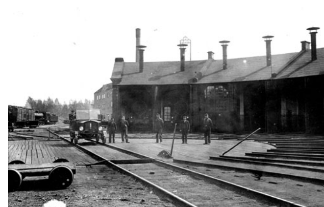
Östra lokstallet. Fotograf: okänd. Fotoår: okänt. Rättighet: Forskarföreningen Släkt och Bygd i Bollnäs. Ansvarig utgivare: Östen Händel. Tillstånd av ansvarig utgivare: Östen Händel.
