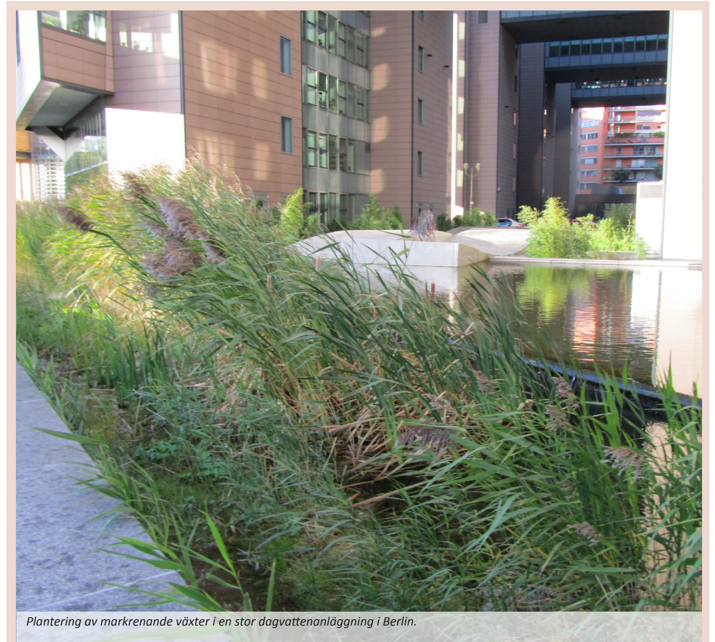
Andmat skördas och nya planter planteras in för att få bort föroreningar från vattnet.
