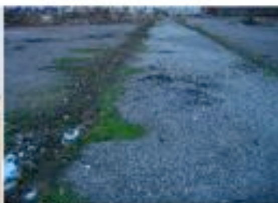
Figur 6: Spår av järnväg
