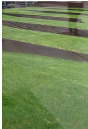
Cortenstålskanter som nivå-avskiljare ger ett spännande uttryck i en sluttande gräsyta. Projekt Grundgesetz, Tyskland. Arkitekt Dani Karavan
