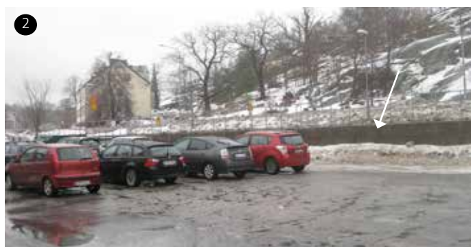
Barriär: en mur som tar upp nivåskillnaden mellan vägen och parkeringen. Åtgärd: för att främja flödet av människor till Gustavsbergs hamn bör muren öppnas upp med trappor och ramper.
