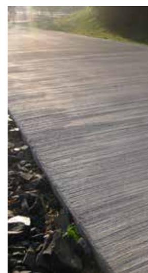
Gångstråk av räfflad betong ger fin struktur åt ytan. Park am Gleisdreieck, Tyskland. Arkitekt Atelier LOIDL
