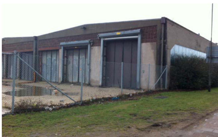
Kv. Spårvägens nord-östra hörn (bild 27)
