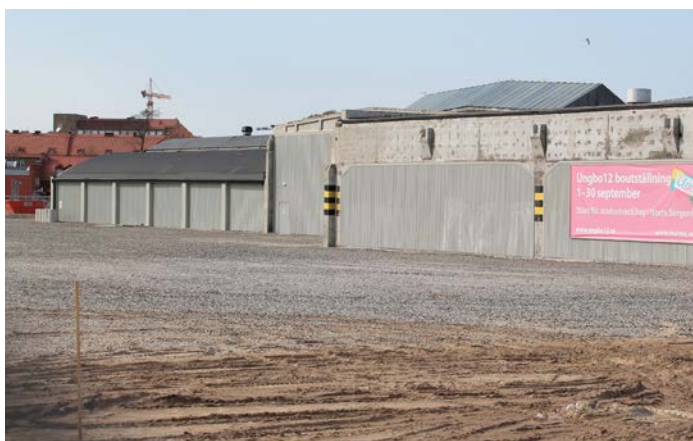
Ödehuset tillhörde förr AB Alfred Benzons fabrik (v) och spårvagnshallarna idag (h) (bild 15,16)
