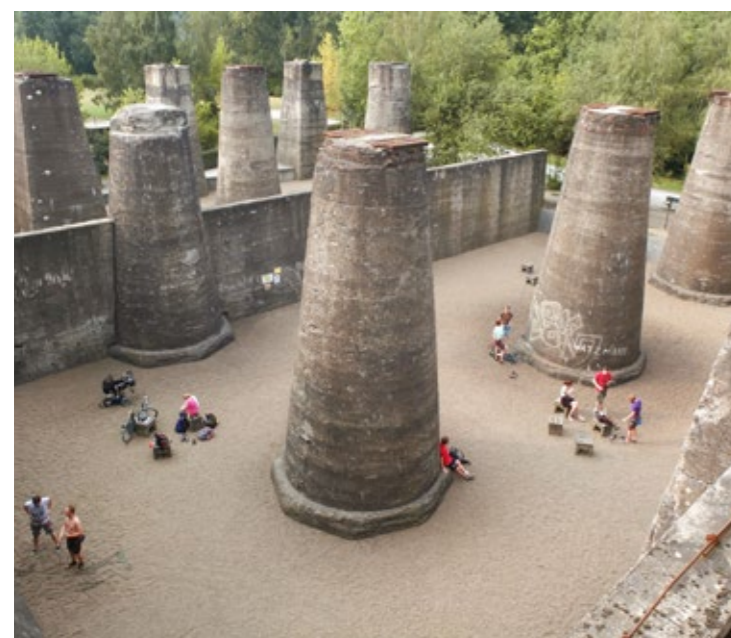
Klättring på gamla betongfundament vid Duisburg Nord, Emscherpark . De gamla malmfickorna har omdanats till platser för aktivitet och äventyr.
