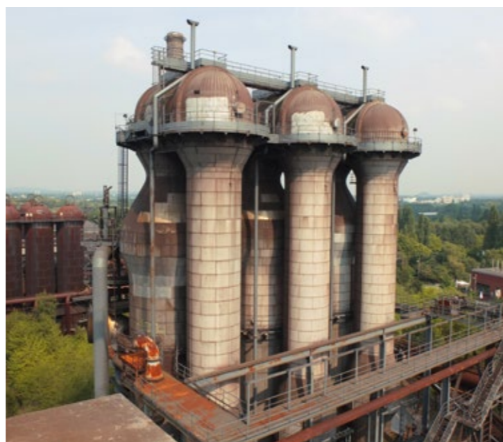
Värmevärmare Duisburg Nord, Emscherpark . Kontrollerad patina, ev. restaureringar görs i enhetlighet med förfallet, ingenting rivs eller tas bort.
