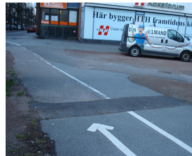
Lappad och lagad asfalt, ej enhetlig markbeläggning.
