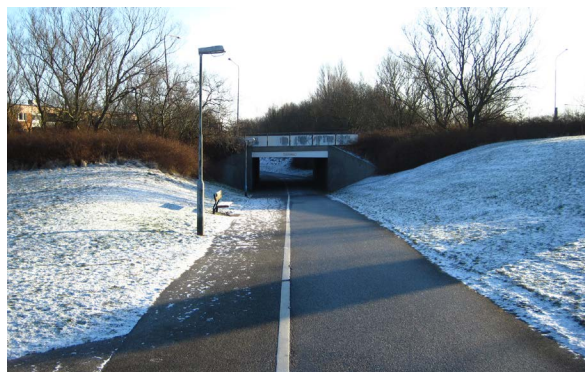
Gång- och cykeltunnel under Eriksfältsgatan
