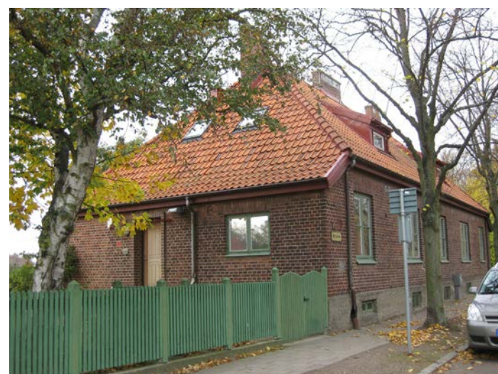
En äldre tegelbyggnad som idag används som kvinnobostad
