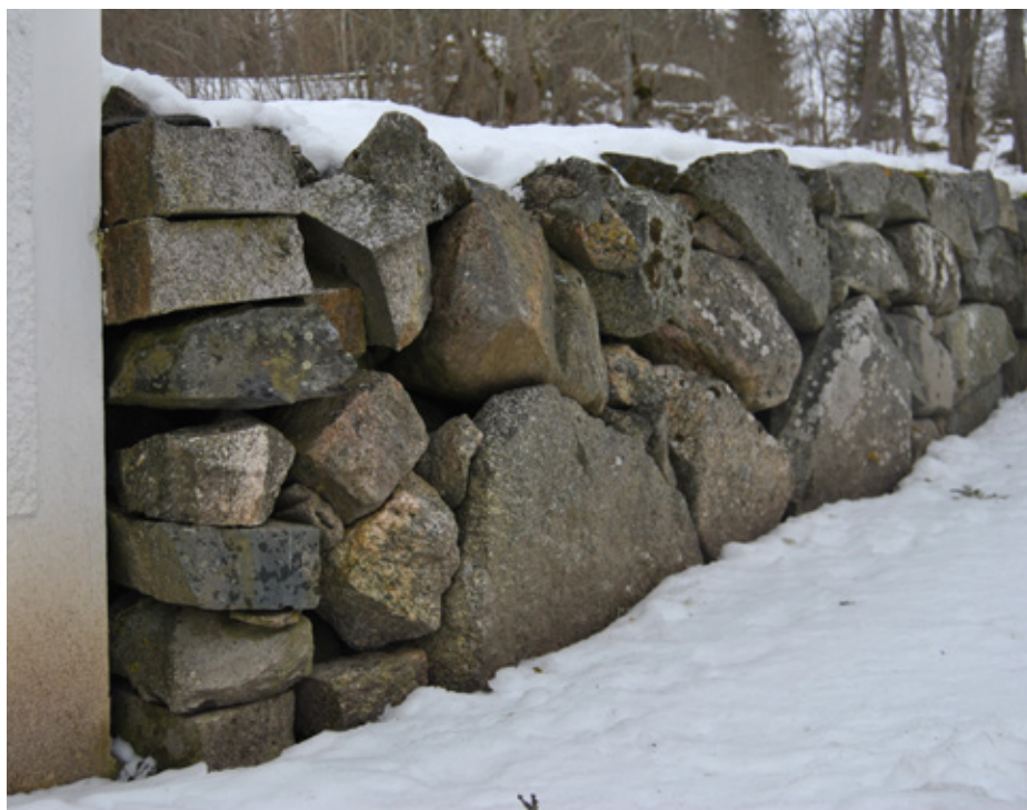
Figur 51. Muren ansluter till huvudentréns ena grindstolpe genom brutna stensocklar.
