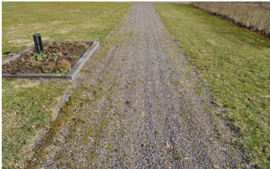
Figur 50. Vissa av den nyare delens grusgångar har inslag av ogräs och mossbeläggning.
