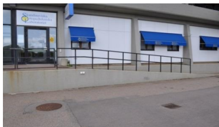
Figur 20. Ramp vid entrén till ortopedtekniska laboratoriet.
