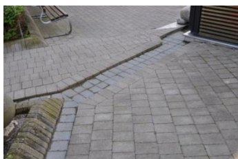
Figur 45. Rännalkanal.
