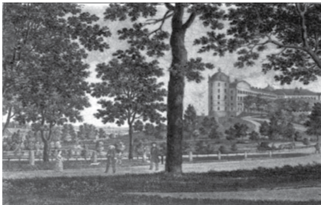
Bild 3. Vy mot Carolinabacken och Uppsalaslott. Upphovsman: Erik Vilhelm Le Moine. Målningen är utförd någon gång mellan åren 1800-1850.
