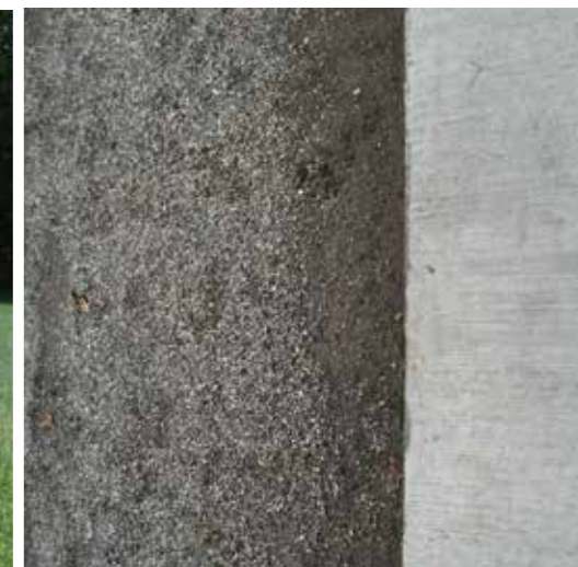
73. Materialmöte mellan grus och betong.
