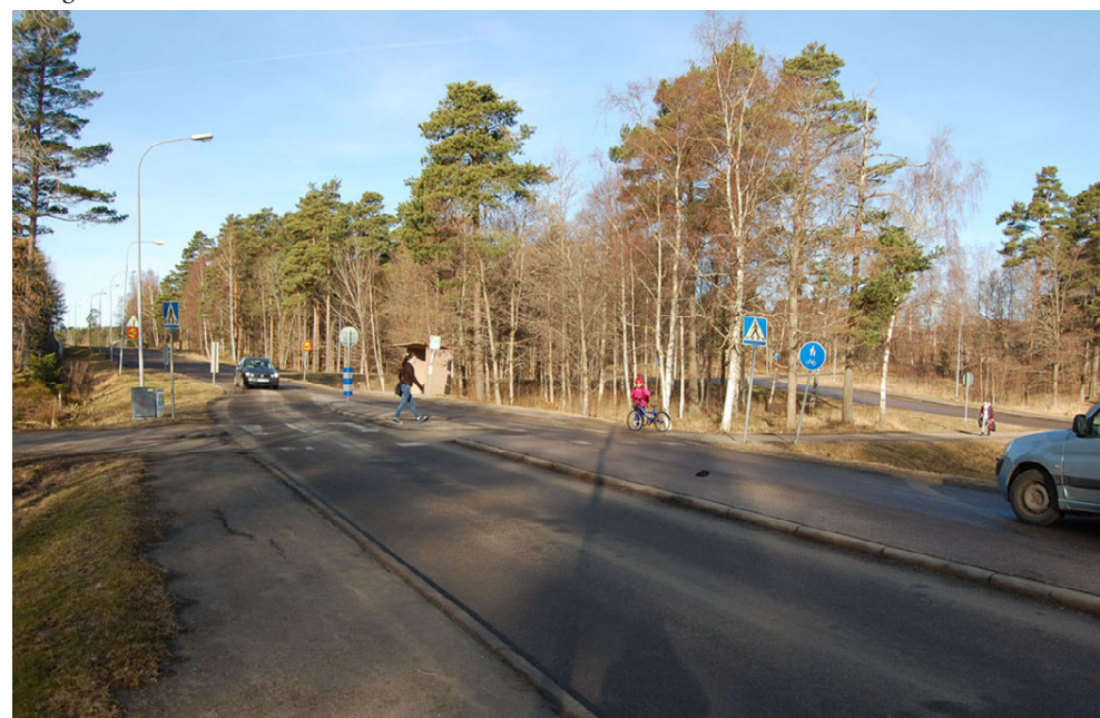
Bild 15. Passage över Trillingbergsvägen alldeles intill skolan. De separerade gång- och cykelbanorna anas i bakgrunden.
