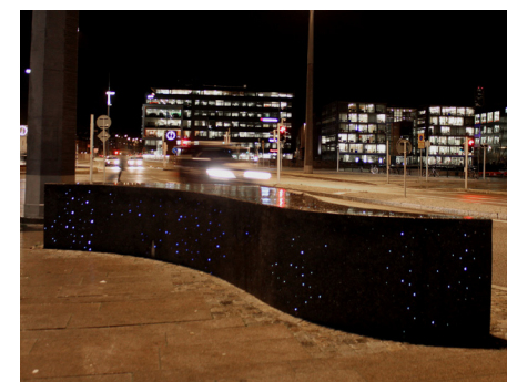
2.21 Betongmur/soffa med infälld fiberoptik.
