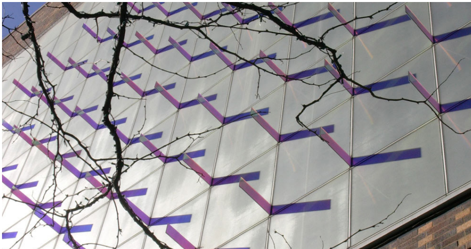
3.20 Dichroic Light Field är en vägg bestående av stavar gjorda av dikroiskt glas.
