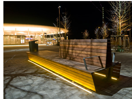
2.24 Integrerad markbelysning lyser upp fronten på bänkarna vid Hyllie stationstorg.
