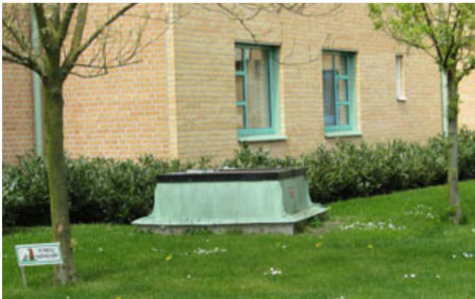
Ventilationshuvor avslöjar det underliggande garaget.
