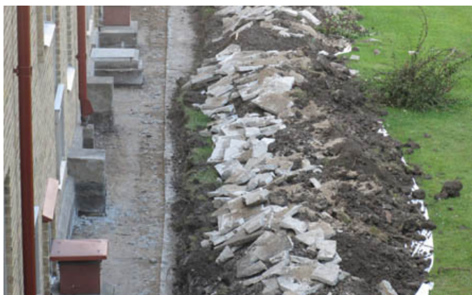
Renovering av garagetak.
