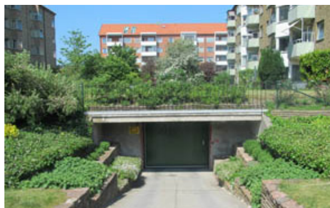
Vid garagedfarten blir det en rejäl höjdskillnad från gården.
