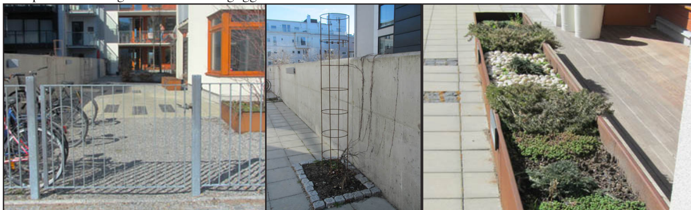
Gården är väl avgränsad med staket och murar. Gårdarnas privata uteplatser kantas av upphöjda planteringar i corten.
