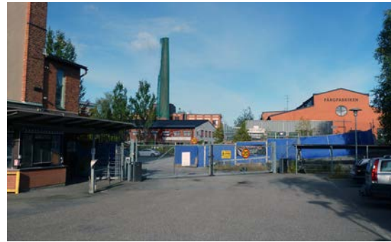
Entré till området. Kontoret t.v.
