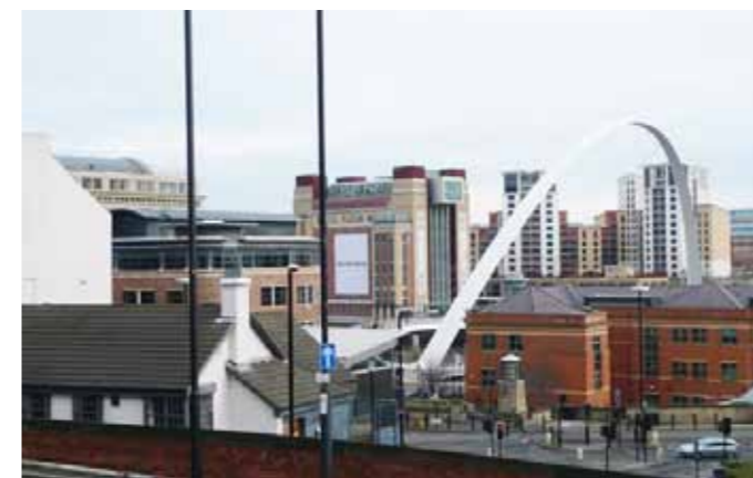
Gateshead millennium bridge, Newcastle, Storbritannien. Foto publiceras med tillstånd av Jacob Kindstedt.
