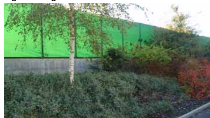
Baksidan av bullerskärmen mot bostadsområdet med vegetation.
