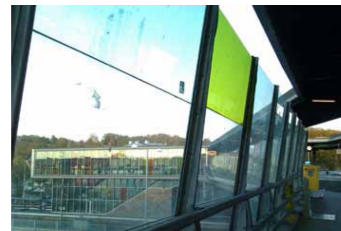
Bullerglas på bron över E6:an med delar av Mölndals station i bakgrunden.
