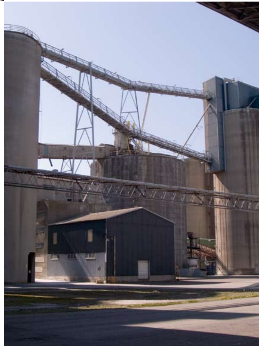
Bild 35: betong och transportband
